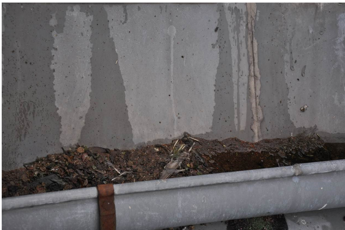
Obrázek 23 - Zanesený okap
