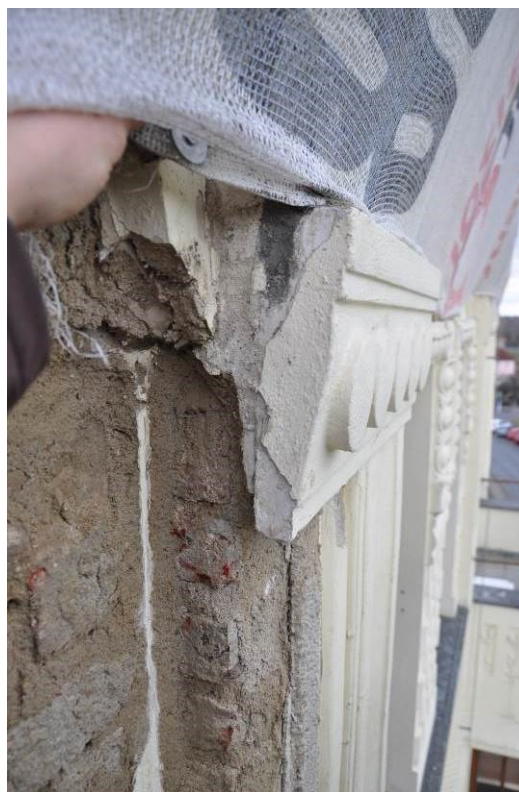
Obrázek 12 - Jižní strana, místo po odpadlé vejcovcové šambráně, na levé části je vidět technika připevnění odlitku
