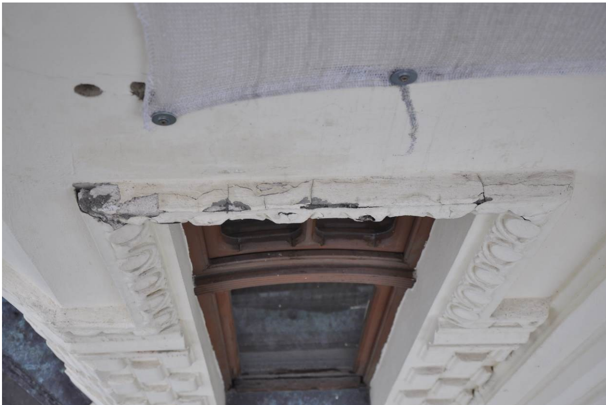
Obrázek 8 - Jižní strana, vrchní pohled na vejcovcovou šambránu, praskliny v materiálu, pod které se dostává voda, degradace materiálu
