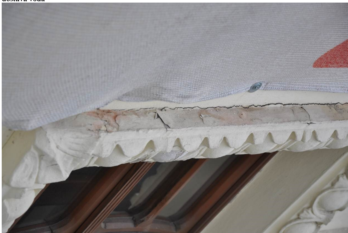
Obrázek 11 - Jižní strana, vrchní pohled na vejcovcovou šambránu, praskliny v materiálu, pod které se dostává voda
