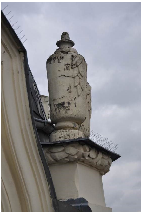
Obrázek 19 - Válcová váza na atice okoseného nároží, horizontální praskliny, degradace nátěru a odlévacího materiálu
