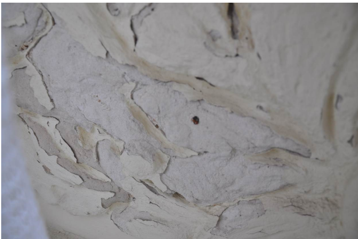
Obrázek 21 - Poškození nátěru na sádrovém štuk, degradace sádrové štukové malty
