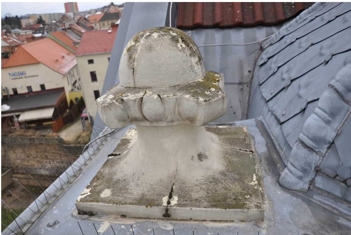
Obrázek 17 - Šiška na hranaté váze s vejcovcovým dekorem – biologické napadení po celém povrchu, v prasklinách se usídlují mechy
