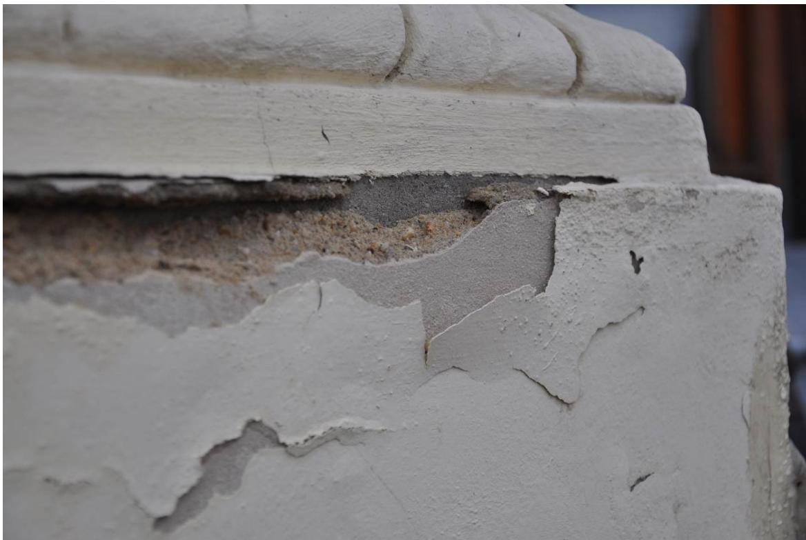
Obrázek 15 - Detail ztráty adheze různých materiálů - akrylátový nátěr, štuk, jádrová omítka, nejhůře drží nátěr na svém podkladu
