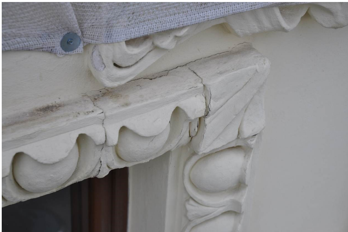
Obrázek 10 - Jižní strana, vrchní pohled na vejcovcovou šambránu, praskliny v materiálu, pod které se dostává voda
