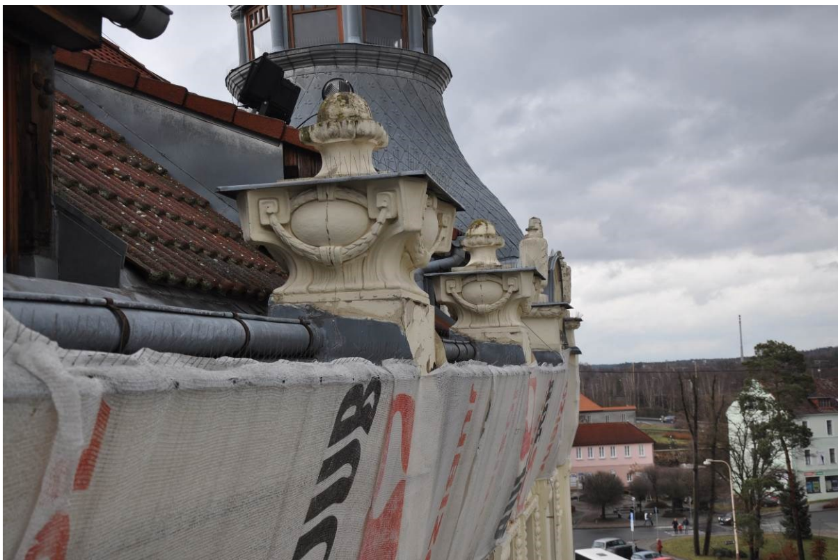
Obrázek 16 - Pohled na hranaté vázy ze strany, prasklina v místech předpokládaného lepeného spoje
