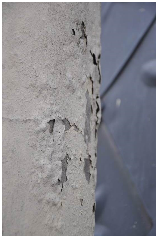
Obrázek 20 - Detail poškození nátěru na vápenném odlitku
